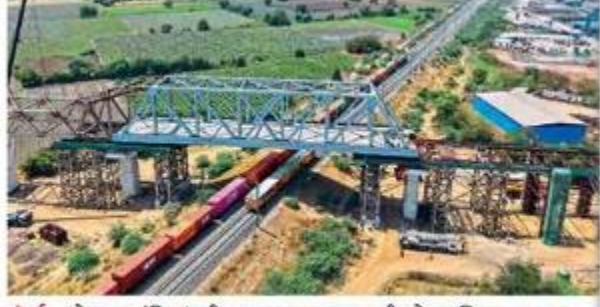
मुंबई : -'मेक इन इंडिया' स्टील पूल नुकताच यशस्वीपणे बसविण्यात आला.
