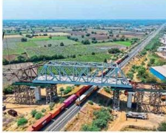
मुंबई : बुलेट ट्रेन प्रकल्पांतर्गत बडोदाजवळ स्टील पूल बसवण्यात आला आहे.
